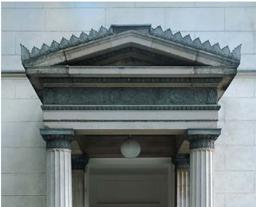
Abbildung 7: Ornamentspenglerei am Schloss Glienicke, das 1825 bis 1828 durch Karl Friedrich Schinkel erbaut wurde.
