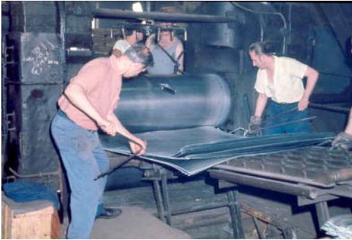
Abbildung 6: Herstellung von Zinktafeln im Paketwalzverfahren
